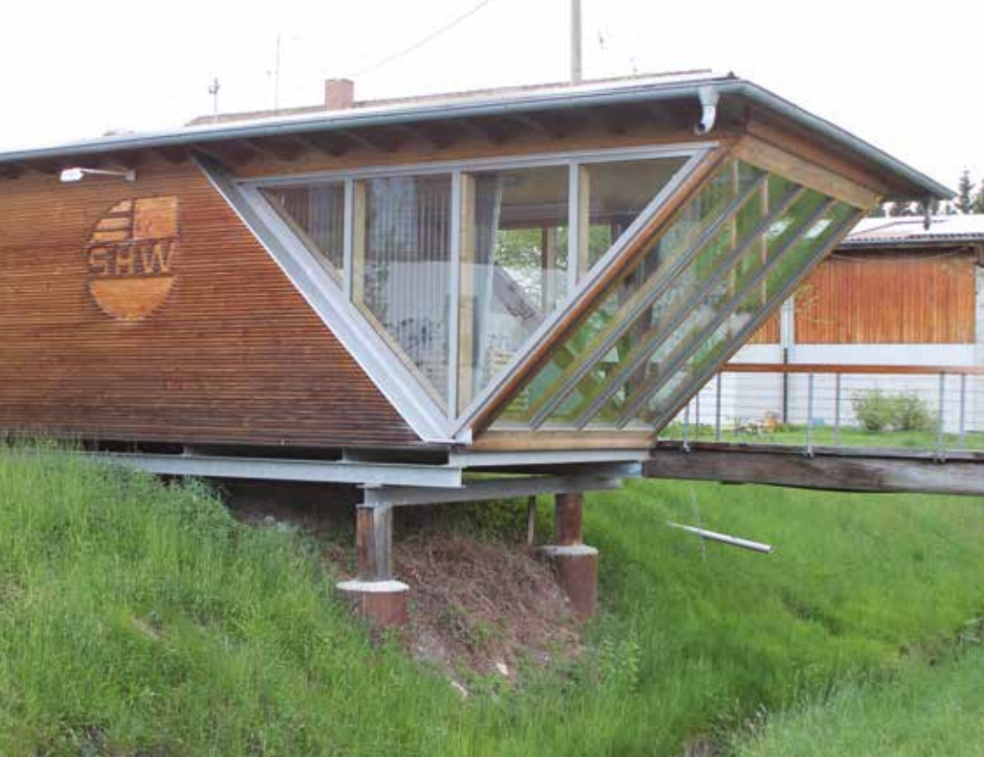
Das Bürogebäude des Sägewerks wurde natürlich aus Holz gebaut und gleicht optisch einem Bretterstapel.
